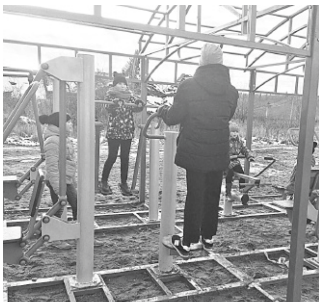
Ещё идут последние работы, а детям уже не терпится опробовать новые тренажёры
